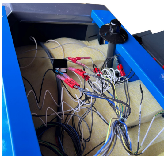
9. Placér AS Timeren oven på isoleringen i kedlen.
